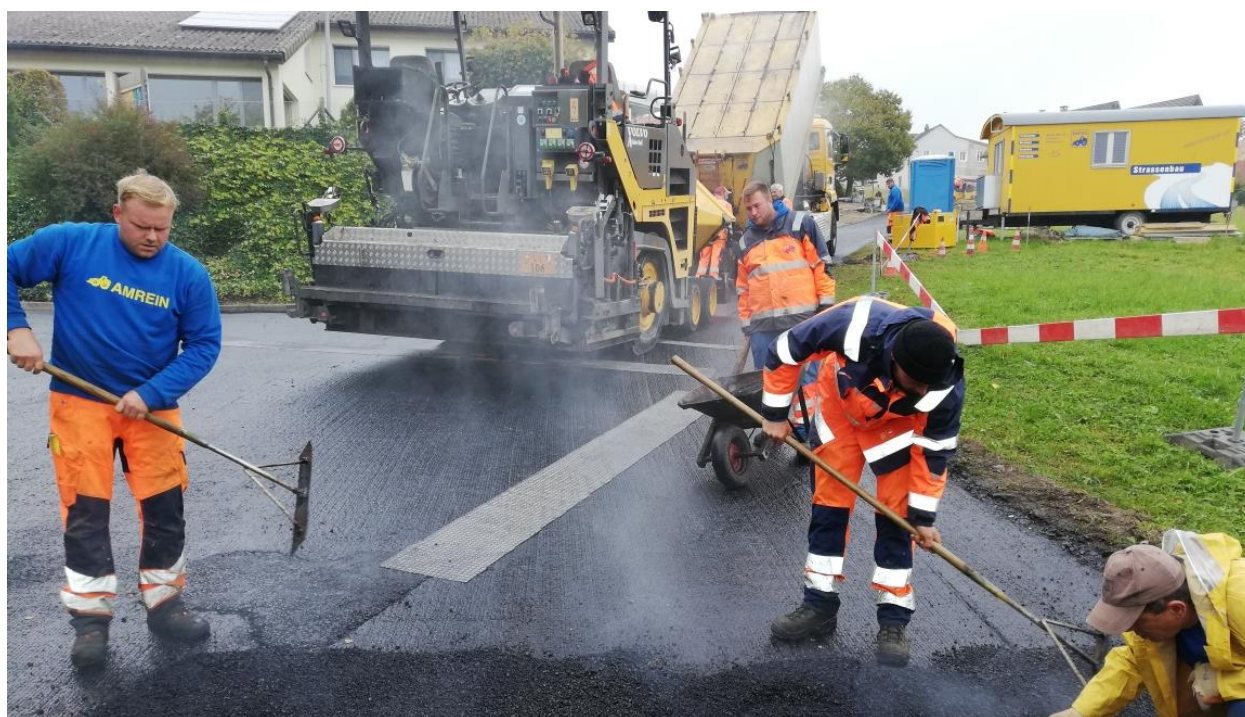
Strassensanierungsarbeiten in Müswangen
