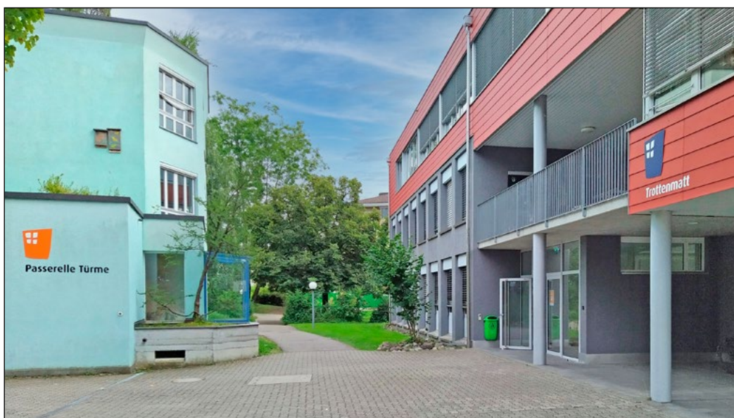
Blick auf den neuen Windfang beim Schulhaus Trottenmatt und die Schulhausbeschriftungen
