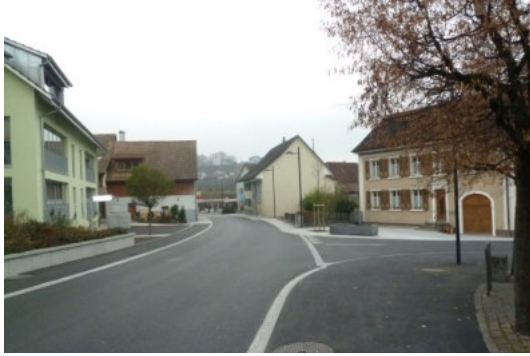
Abbildung 72: Umgestaltete Ortsdurchfahrt in Döttigen
