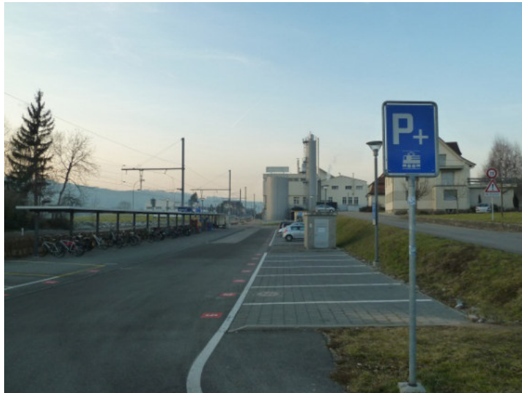
Abbildung 76: Park & Ride-Anlage Bahnhof Richensee
